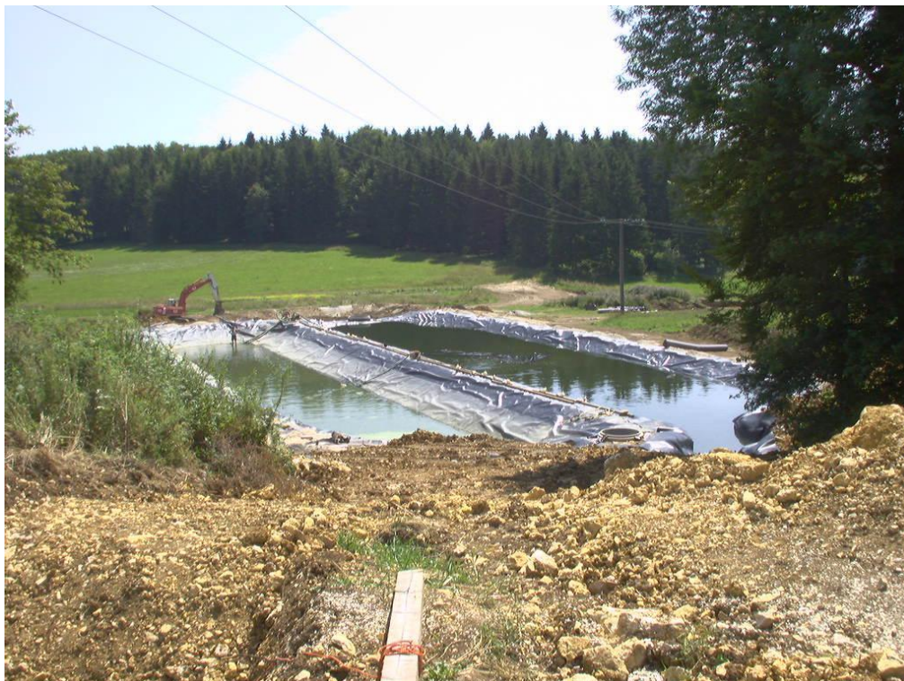
Foto: Becken im Rohbau
