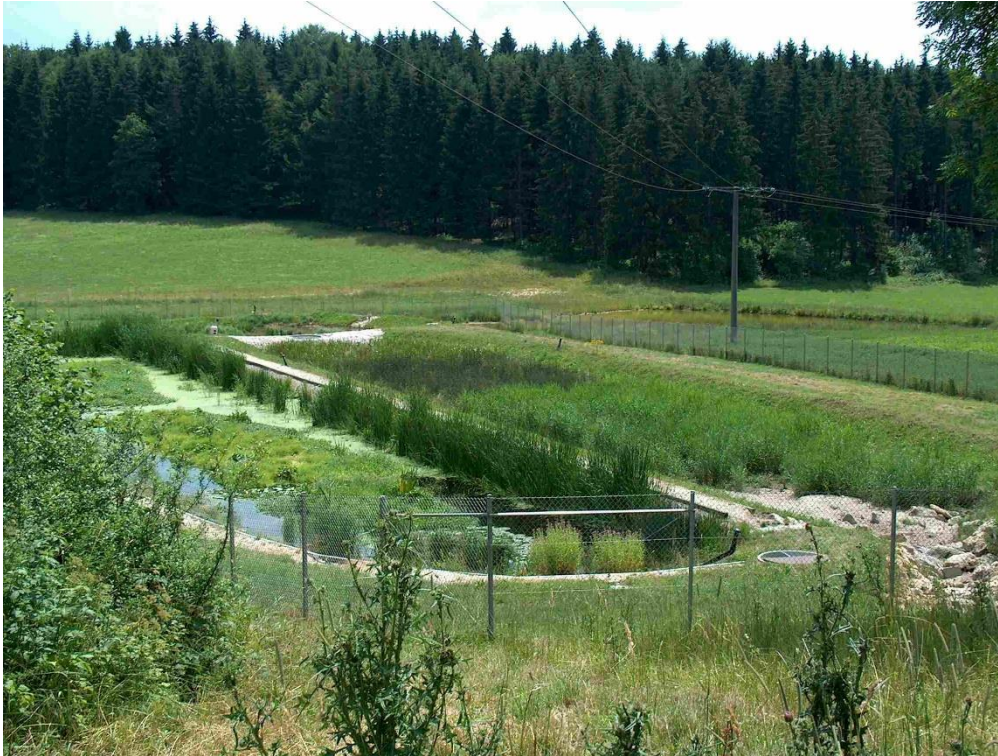
Foto: Anlage im zweiten Betriebsjahr, links Nachklärteich, rechts Retentionsbodenfilter, dahinter Versickerungsareal, im Hintergrund rechts Damm mit Infiltrationsfläche
