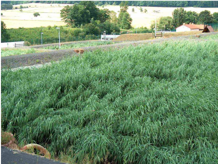
Một trong 4 bãi lọc lau sậy trong hệ thống xử lý nước thải đô thị ở Bad Emstal (6,000 m 2 in total)
