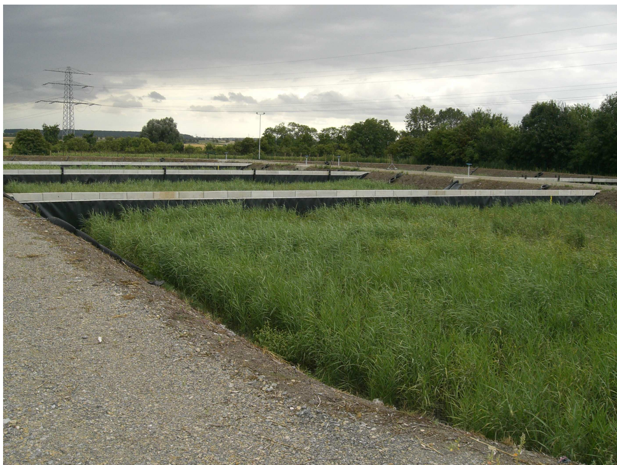
Tratamiento natural de lodos en bancales en Lahstedt (Gross Lafferde)
